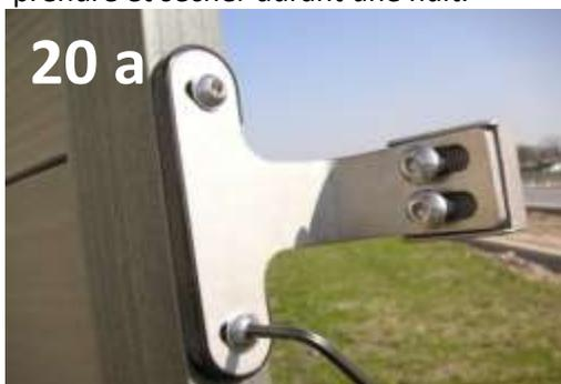
**20a** Fixez les charnières sur la porte. Sur le chant de la porte, deux trous sont prévus dans le haut et dans le bas pour la fixation des charnières. Placez-les sur le chant de la porte et fixez-les. Utilisez pour ce faire les vis fournies M8 x 25 mm et les rondelles plates M8. Vissez avec une clé Allen n°5.
